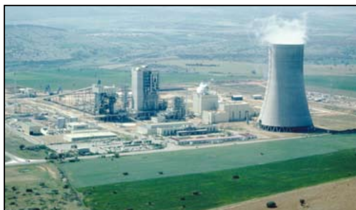
Central Térmica GICC (Gasificación Integrada en Ciclo Combinado) de Puertollano, perteneciente a ELCOGAS, S.A. Fuente: ELCOGAS, S.A
