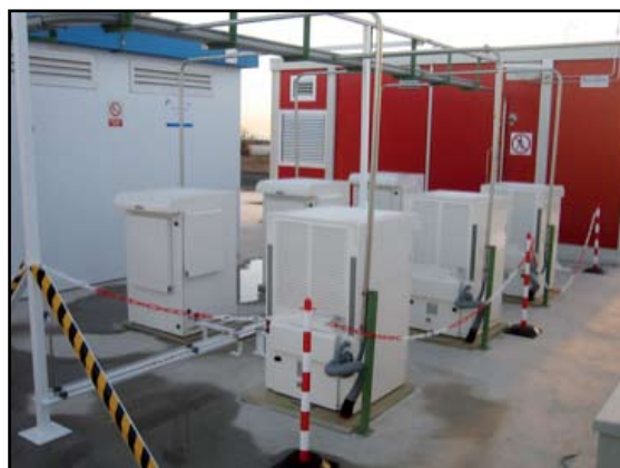
Instalación de 6 pilas PEM realizada por ARIEMA en Proyecto RES2H2. Fuente: ARIEMA
